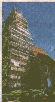
Der Turm des gotischen Backbaus wurde für die Helmerneuerung komplett eingerüstet.
